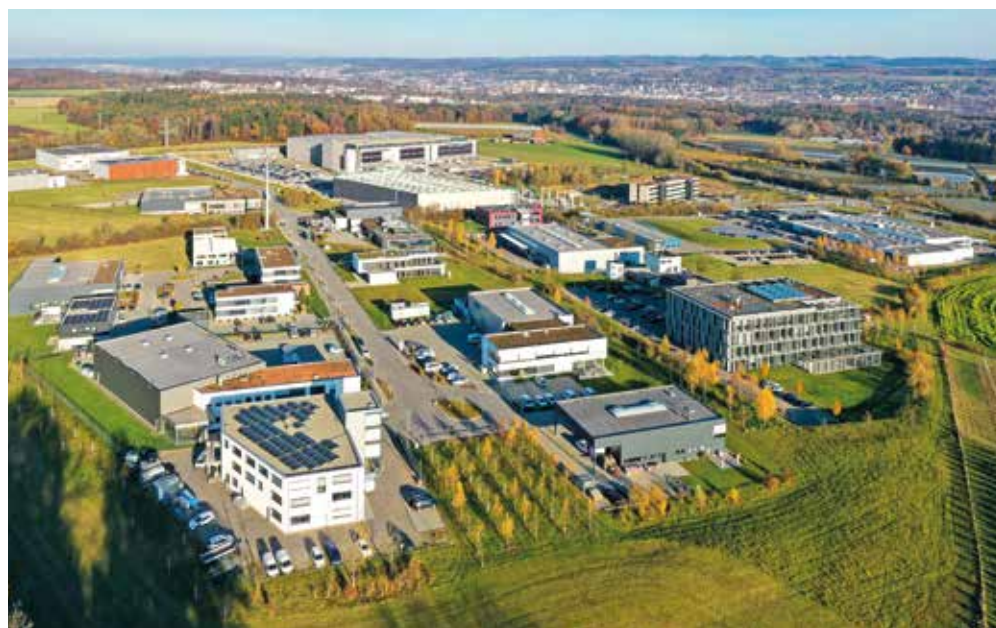
Vista de Gewerbegebiet Erlen, una zona comercial a l'oest del centre de Ravensburg creada fa uns anys per donar espai a l'establiment i l'ampliació d'empreses (destaca l'empresa Vetter Pharma)
