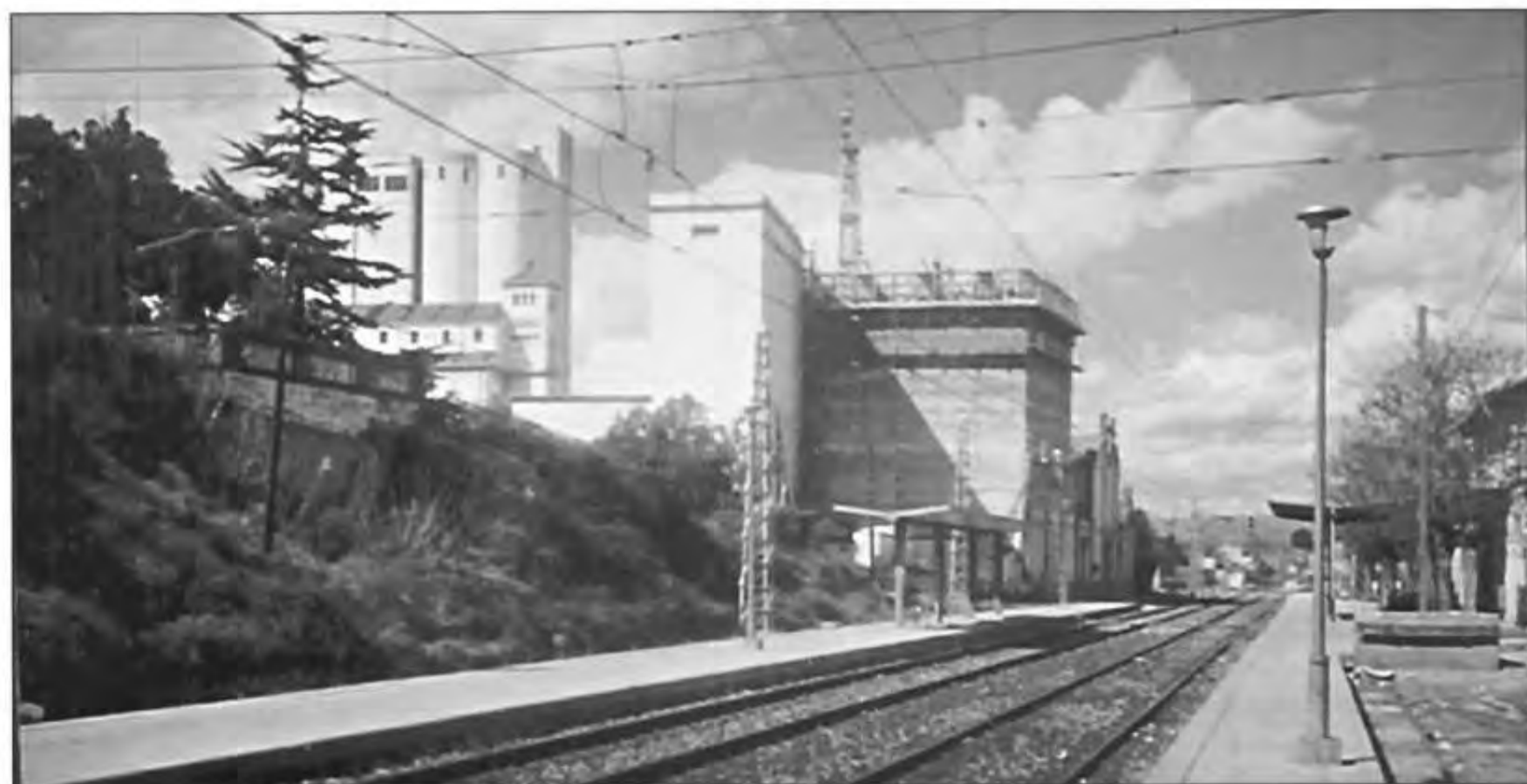
Fotografia 43 - Construcció de sitges de farna
