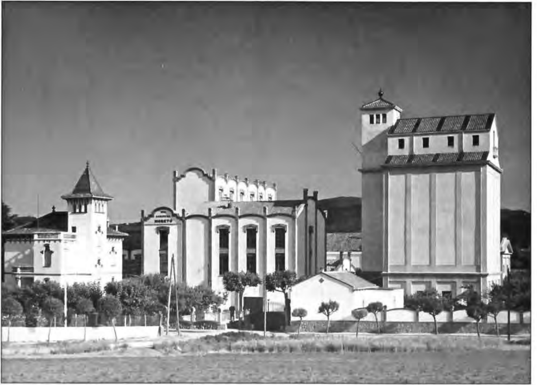
Fotografia 39 – Vista del conjunt amb les sitges, a la dreta, l'any 1929
