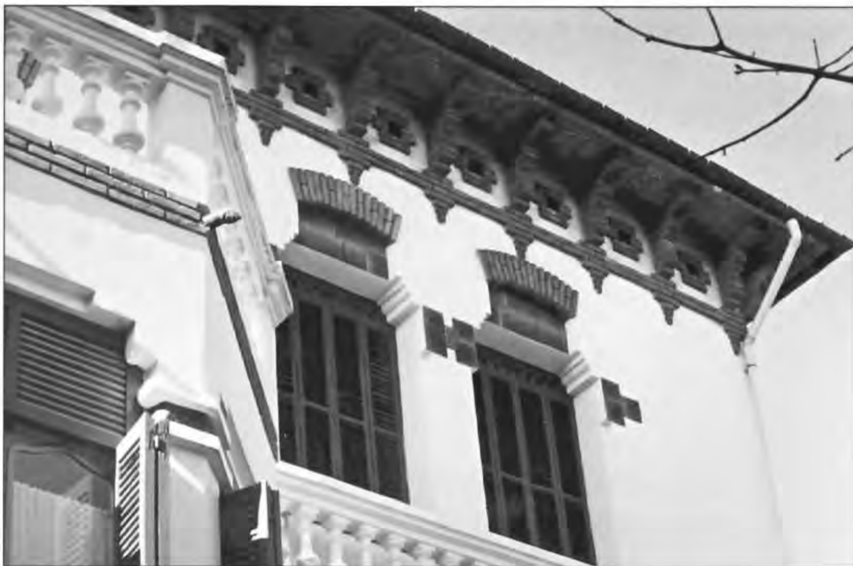
Fotografia 25 - Detall de la cornisa i les finestres
