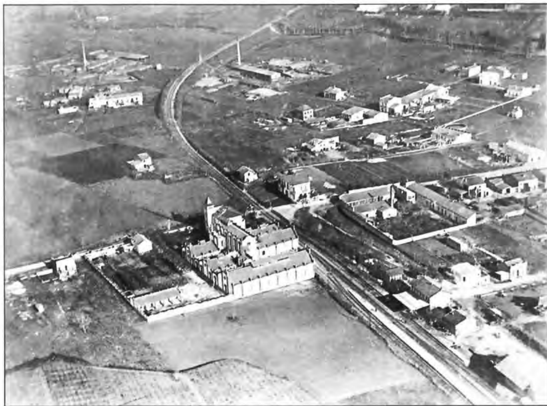
Fotografia 3 - Vista aèrea de la Farinera de Santa Rosa
