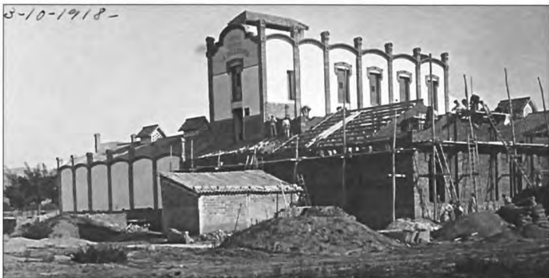
Fotografia 33 - Ensostrament de l'ultima nau
