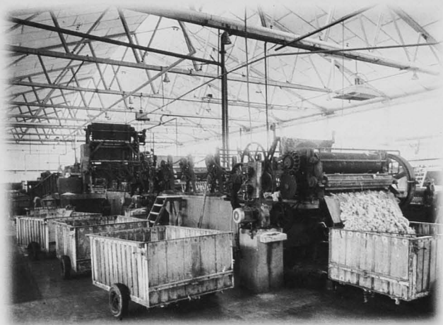
Tren de rentatge modern instal·lat a la Tenería Moderna Franco-Española (actualment eliminat).
