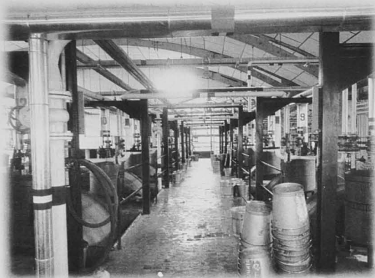
Imatge de la part superior de la instal·lació de bombos rotatoris de polièster, on es fa la càrrega de productes químics per al tractament de les pells.
