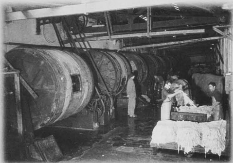
Secció de bombos rotatoris de fusta, on les pells reben tractament químic en la secció de ribera, abans de la fase d'adob.
