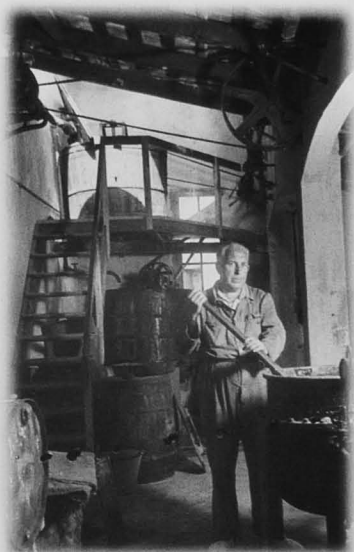
Treballador a les calderes de barreges.
