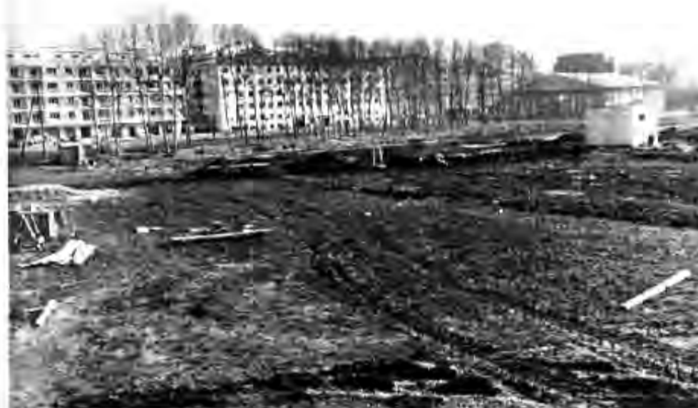
Inici de les obres de l'Institut de batxillerat
