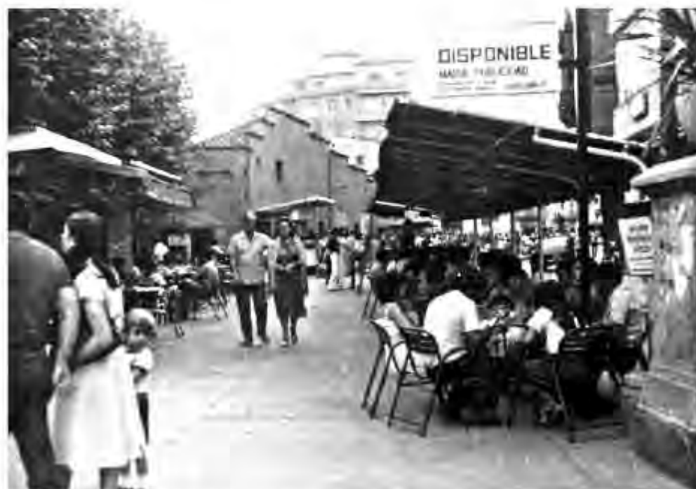
La rambla abans de la seva rehabilitació
