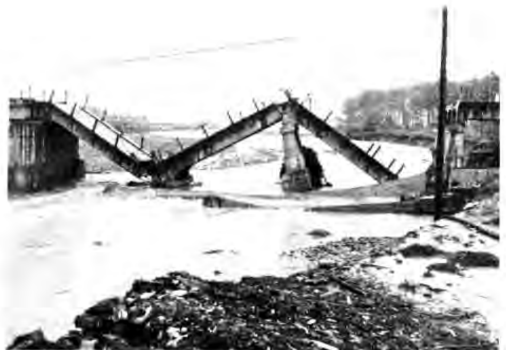
Pont trencat per una revinguda del riu Besòs als anys seixanta
