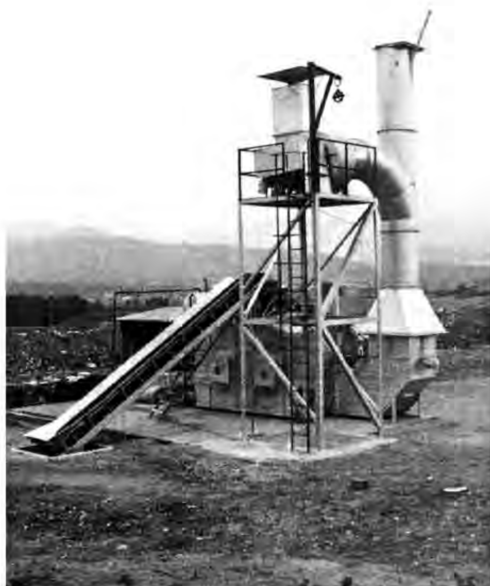
La Planta Incineradora de residus urbans
