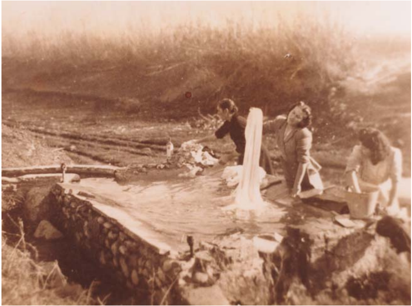
Safareig de la riera Seca on va caure una bomba durant el segon bombardeig. Arxiu de la Consol Naqui.
