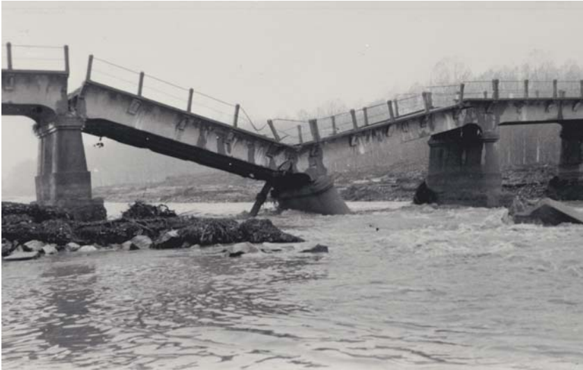
Estat en què va quedar el pont del Besòs després de les inundacions de 1962. (fotografia: Montserrat i Núria Ros).
