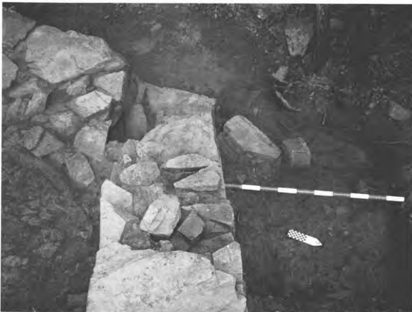
Fig. 4: Imatge del desviament de 140^\circ de la cantonada nord del mur perimetral.
