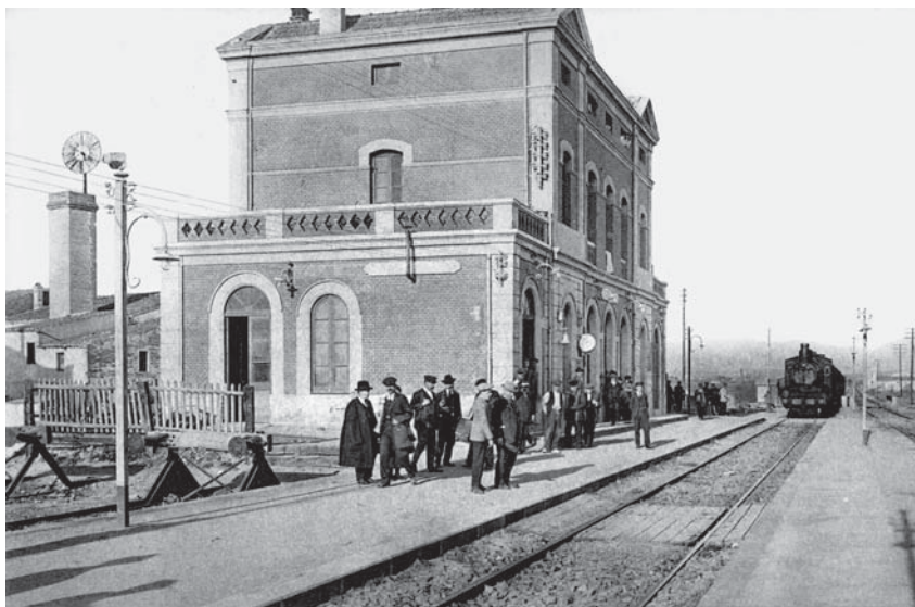
Al final de la guerra, un tren ple de material i menjar va quedar estacionat a l'estació de França. Foto: L'ABANS.
