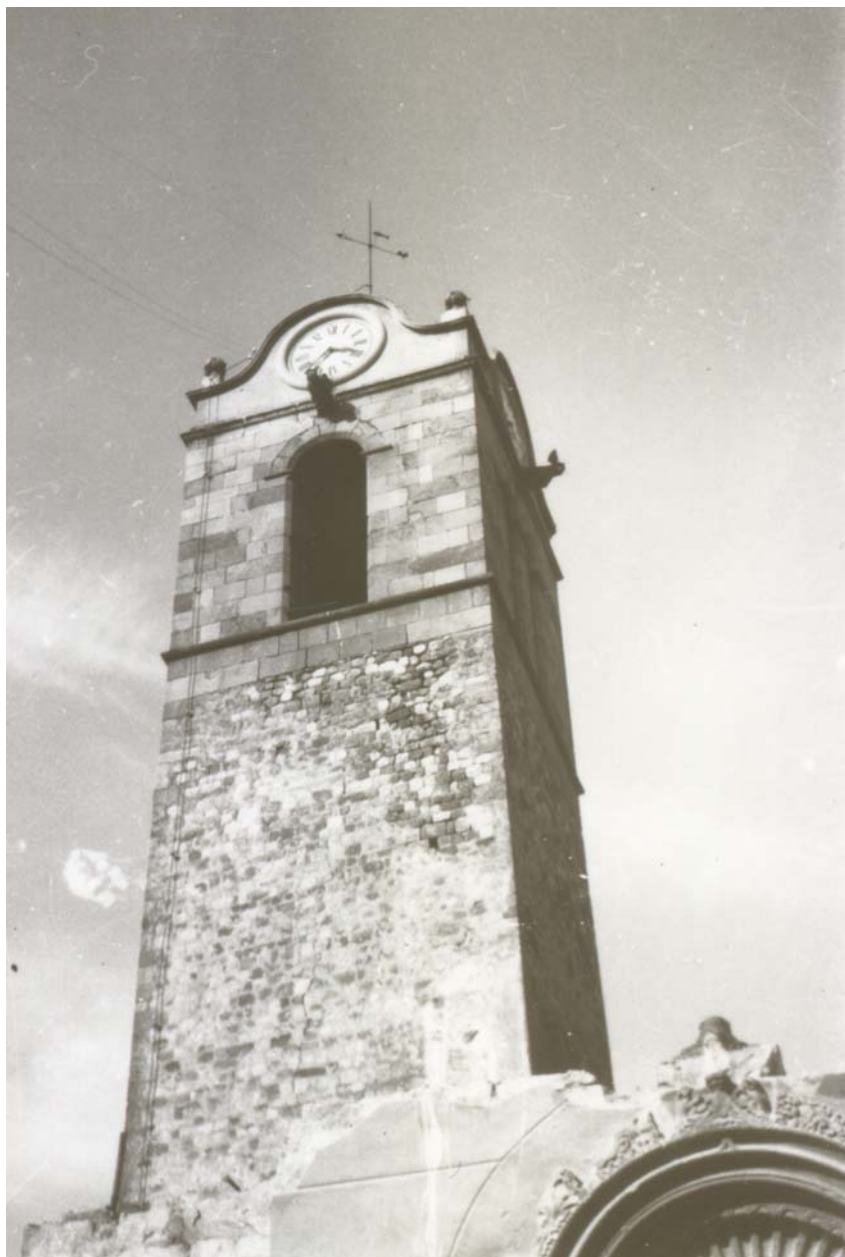
L'Ajuntament va fer instal·lar una sirena al campanar per avisar en cas de bombardeig. Les campanes ja s'havien tret.
