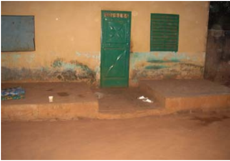
Entrada de l'habitació del Kemu Faty, des del pati central de la casa.
