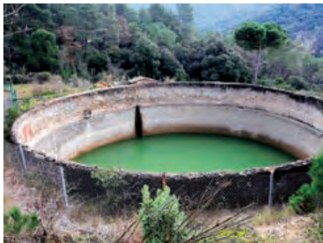
Figura 1. Gran bassa o dipòsit de 10 metres de profunditat
