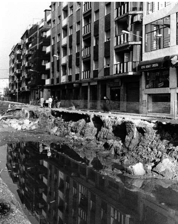
Figura 7. Obres a la Rambla de Mollet. 1996
