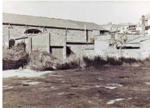
Figura 2. Local on inicialment va començar a funcionar la fàbrica. Després s'hi va edificar el Centre Parroquial i actualment una part l'ocupa la sala Fiveller
