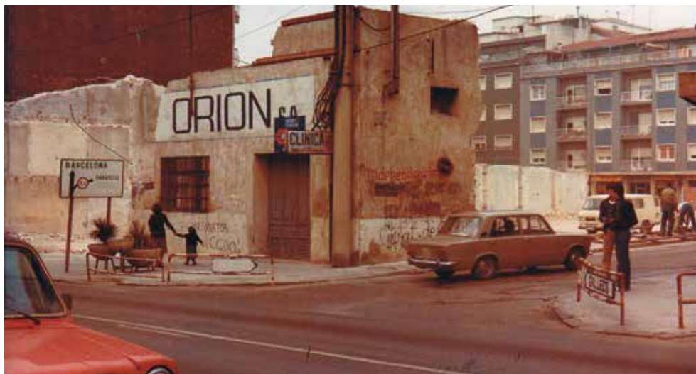
Figura 15. El 1974 es va vendre el solar del Cotó per construir habitatges. Encara es pot llegir el nom de l'empresa que tenia llogat l'edifici, Cartonajes Orión
