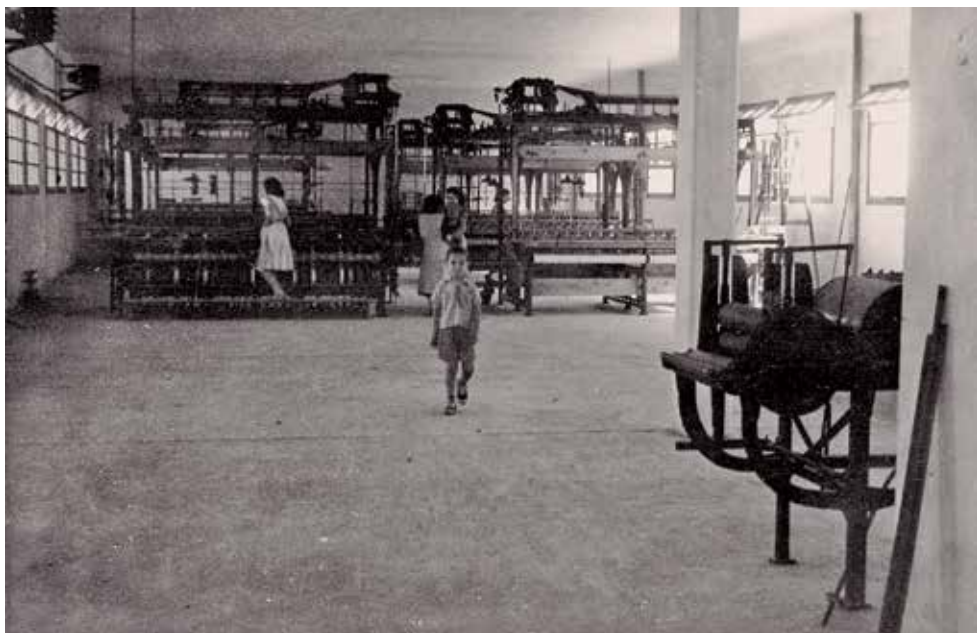
Figura 2. Muntatge de telers a la nova nau d'Oliveras i Martí, al c/Bernat Metge, l'estiu de 1950
