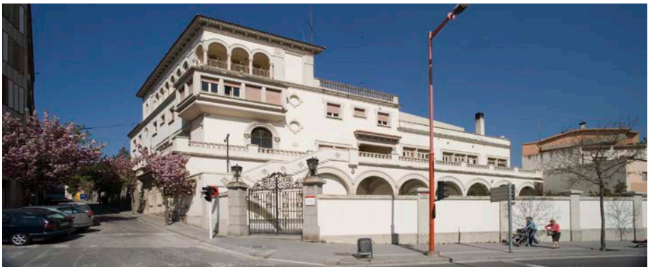
Figura 1. Edifici de Can Gomà. Font: Ferran Mateo, Ajuntament de Mollet del Vallès
