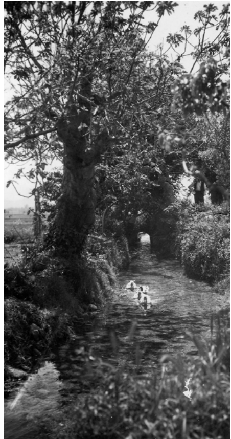
Figura 12. Mina de Can Magre, dècada de 1940. Font: AHMMV
