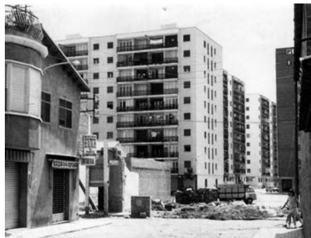
Figura 20. El creixement urbanístic va fer que s'hagués de redissenyar la xarxa viària. A la imatge veiem les obres del carrer de Brutau per comunicar l'avenida La Paz (avui, Primer de Maig) amb la N-152 (avui, avinguda de l'Onze de Setembre), any 1969. Font: AHMLL
