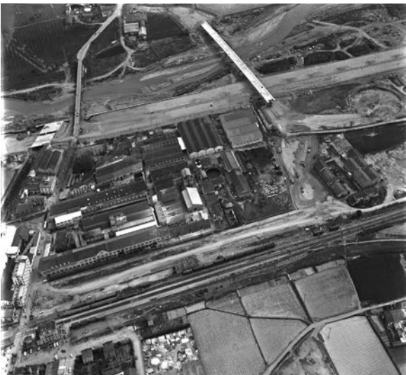
Figura 14. Vista aèria de les obres de construcció de l'autopista AP-7 (C-33), encaixada entre la Pelleria i el riu Besòs. Sobre el nou traçat viari, i d'esquerra a dreta, la plataforma sobre el torrent Caganell, el pont vell i el pont nou. En primer terme a l'esquerra, l'antiga estació de França. Març de 1969. Font: ICGC, Fons SACE
