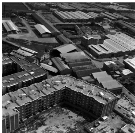
Figura 7. El polígon va anar creixent ràpidament. Al 1976 ja s'havien substituït els camps de conreu per fàbriques. Comprovem també com els blocs de pisos es van construir just al costat de les indústries. Font: ICGC, Fons SACE
