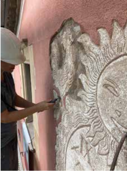
Figura 3. Tall de les vores de l'esgrafi i aplicació de bisells. Font: Cristina Macho i Elena Moral.
