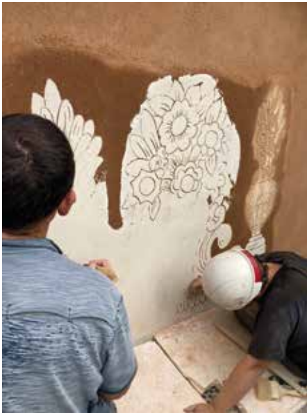
Figura 2. Quatre imatges del procés de restauració de l'esgrafiats amb decoració figurativa. Font: Cristina Macho i Elena Moral.
