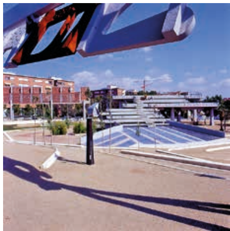
Figura 18. Estructura de grades, que havien de portar a un equipament públic a la part superior. Font: Ajuntament de Mollet del Vallès.
