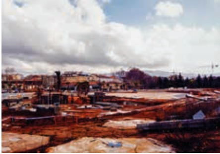
Figura 7. Vista de la construcció del futur parc dels Colors. Font: Ajuntament de Mollet del Vallès.
