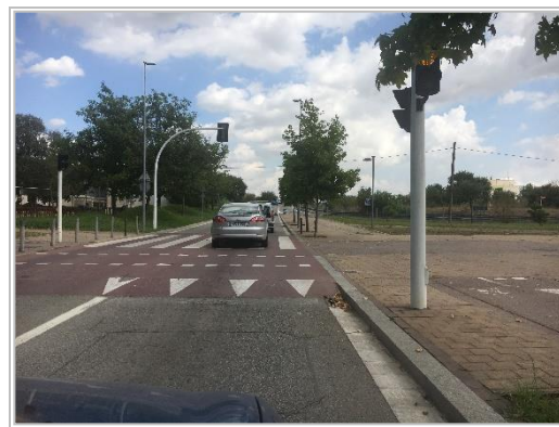
Imatge 17. Pas de vianants i de bicicletes elevat. Font: AIM, elaboració pròpia.
