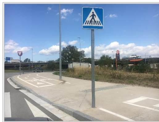
Imatge 26. Falta de l'escaquer al pas de vianants. Font: AIM, elaboració pròpia.
