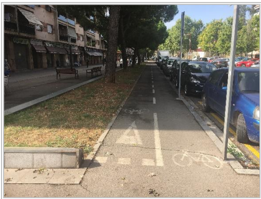
Imatge 12. Espai de vorera bici amb "cediu el pas". Font: AIM, elaboració pròpia.
