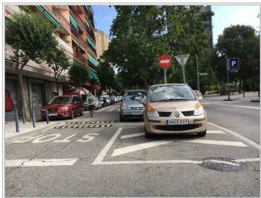
Imatge 29. Doble ressalt d'esquena d'ase a l'avinguda Burgos. Font: AIM, elaboració pròpia.
