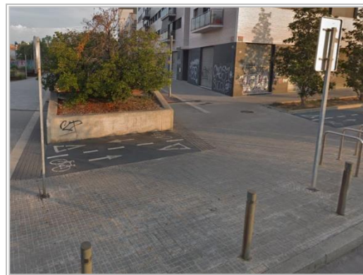
Imatge 24. Interrupció de la senyalització horitzontal de la vorera bici Font: AIM, elaboració pròpia.
