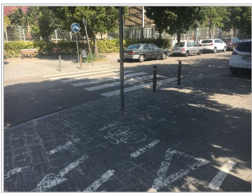
Imatge 21. Manca de connexió al pas de vianants. Font: AIM, elaboració pròpia.
