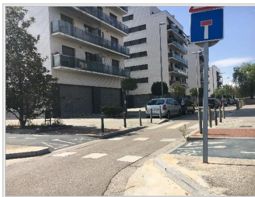
Imatge 22. Pas per a bicicletes separat del pas de vianants. Font: AIM, elaboració pròpia.
