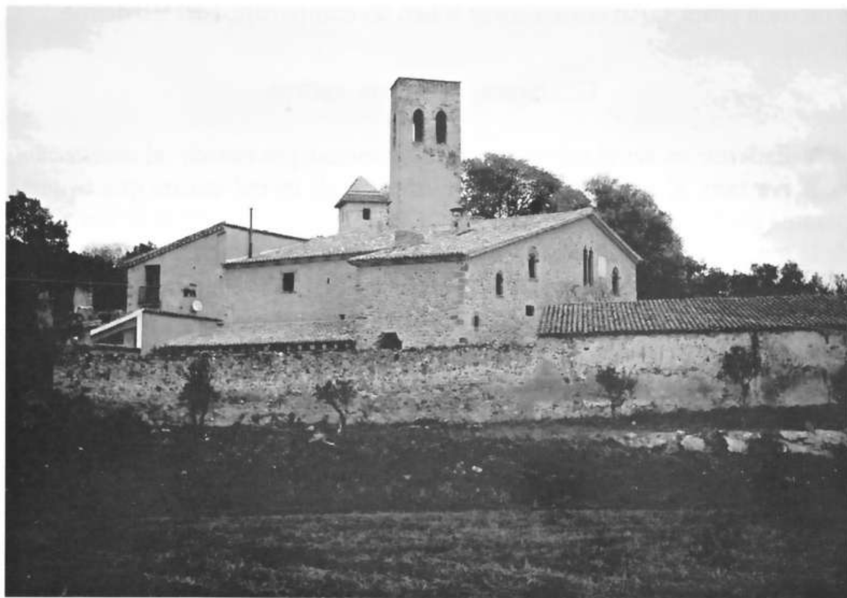
Actual conjunt d'edificacions de Paludàries, aixecades força després del 904. En el mateix indret hi havia, al segle X, un nucli habitat ( villa ), que depenia de la parròquia de Parets.
