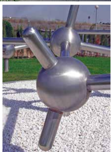
Soldadura per arc elèctric entre les esferes i els tubs que representen respectivament els àtoms i els enllaços químics. S'observa corrosió a la soldadura inferior
