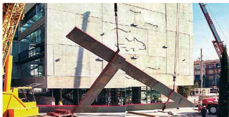
Muntatge i instal·lació de la A
