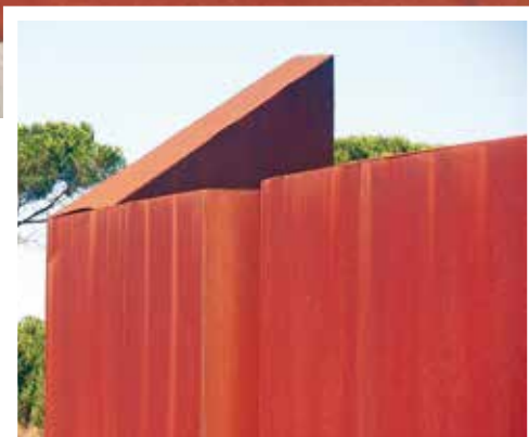
Detall de la soldadura de les xapes Cor-ten®
