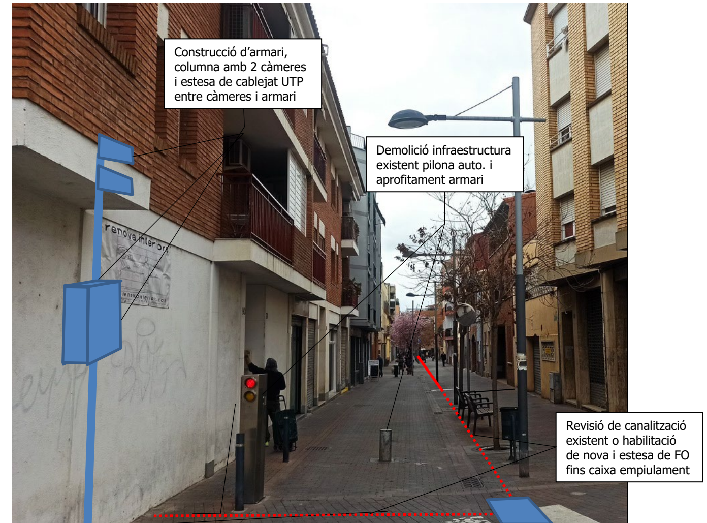
Figura 8. Cablejat necessari node 3
