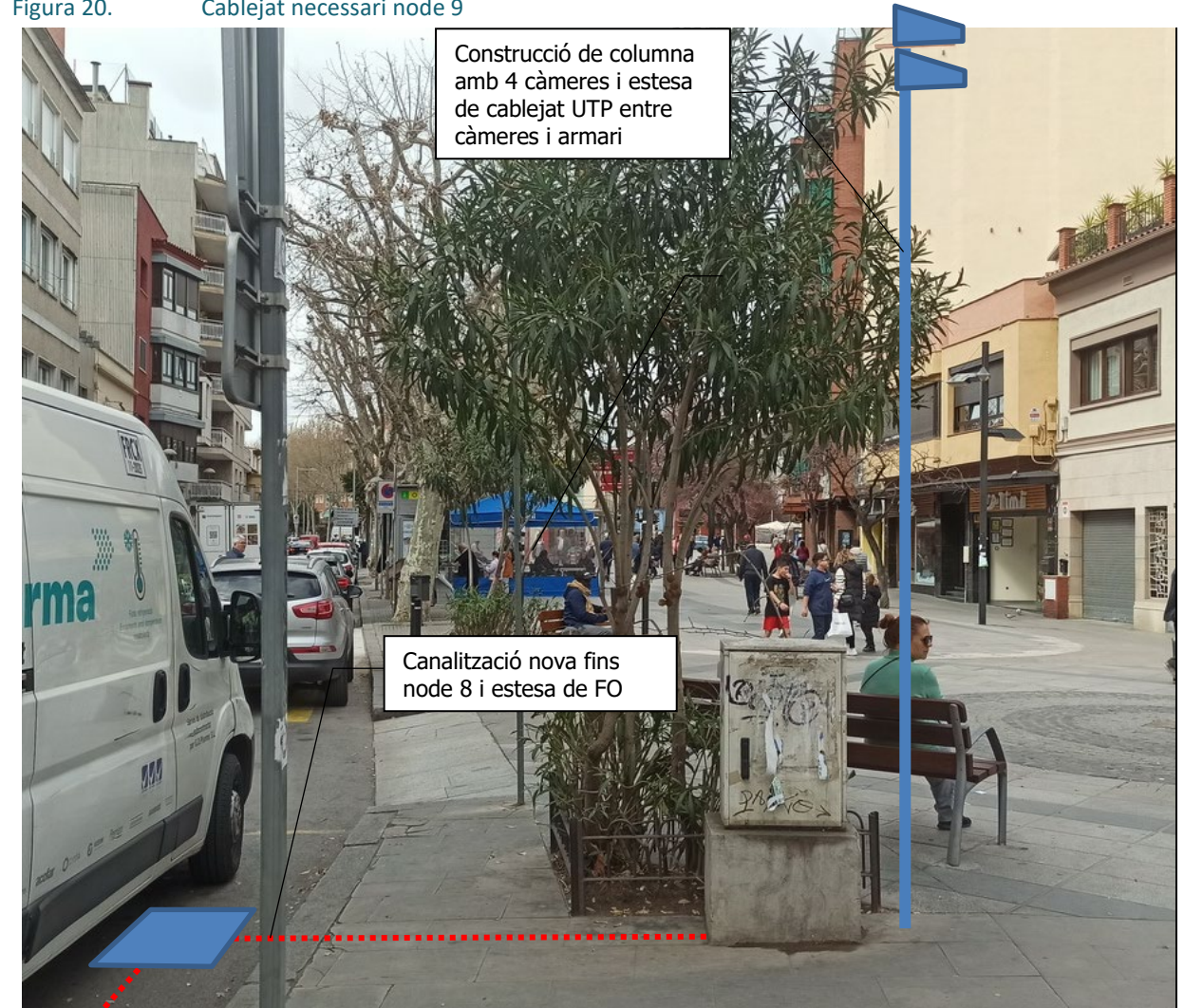
Figura 20. Cablejat necessari node 9
