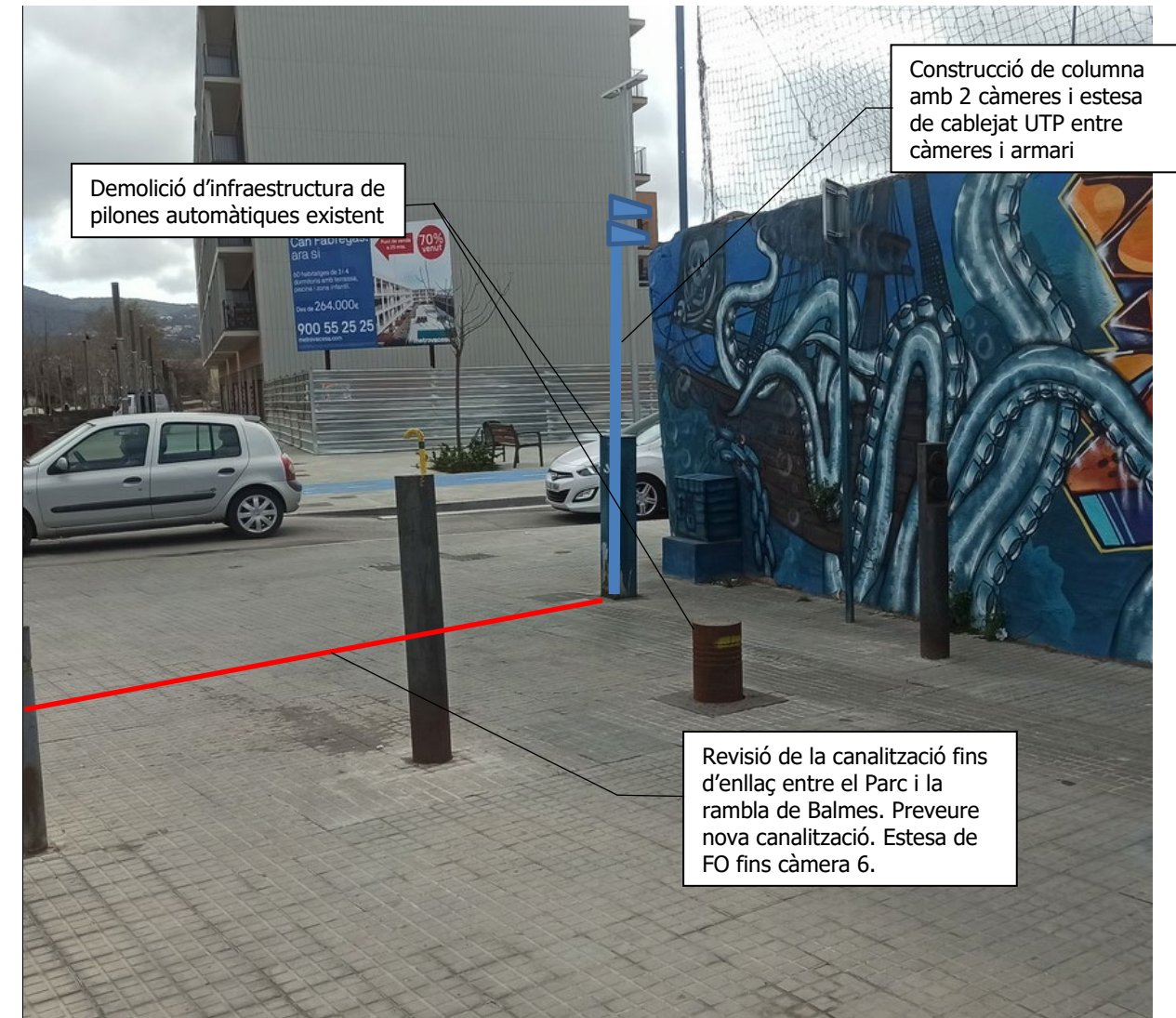
Figura 16. Cablejat necessari node 7
