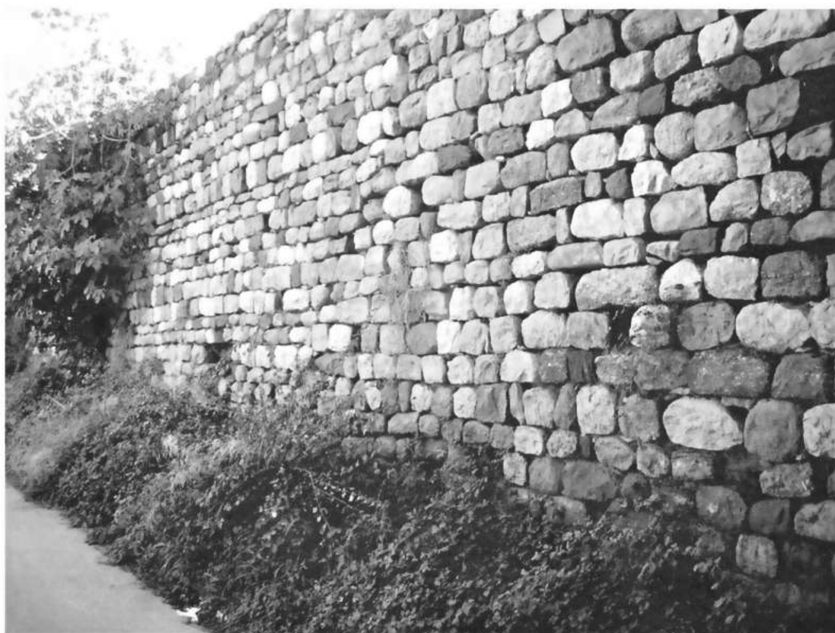
Figura 8 Parament del mur de l'antiga comanda. Les modificacions que al llarg del temps s'han fet del conjunt només han conservat una part, que està orientada al nord-oest del mur
