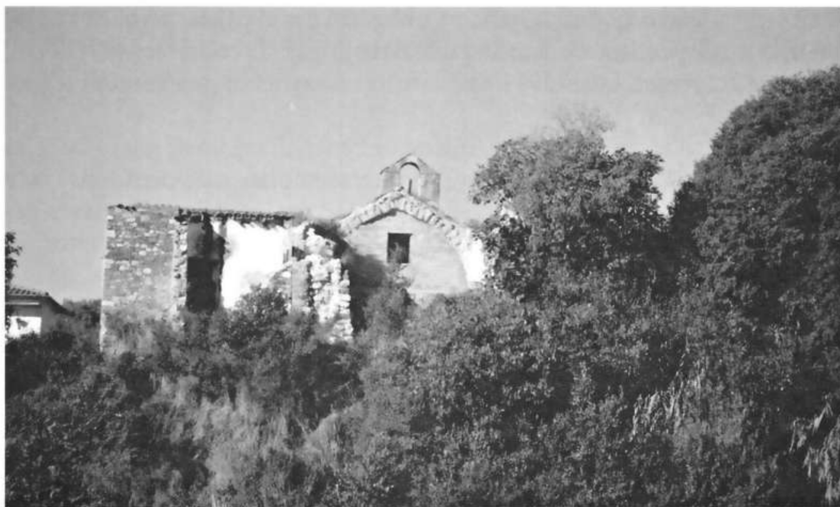
Figura 7 Vista de la capella de la comanda des de la Riera de Caldes. Es pot observar com l'edifici està parcialment destruït, probablement a causa d'una rierada
