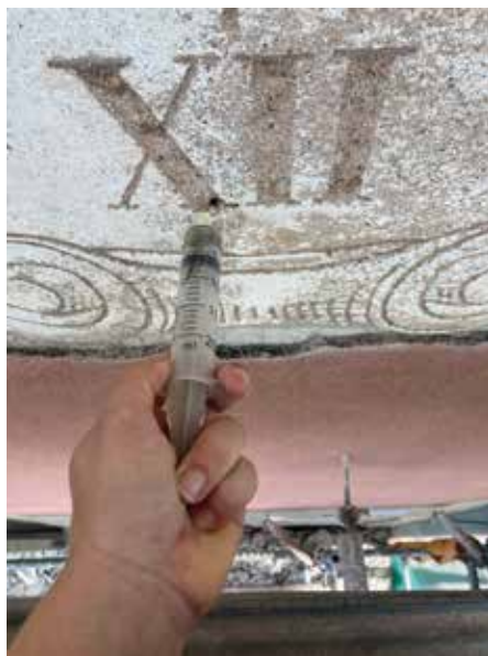
Figura 4. Consolidació de bosses mitjançant injecció de morters específics. Font: Cristina Macho i Elena Moral.
