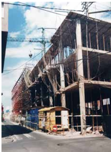
Figura 5. Aixecament de l'estructura del nou edifici, desembre de 1996. Font: Fundació Municipal Joan Abelló.
