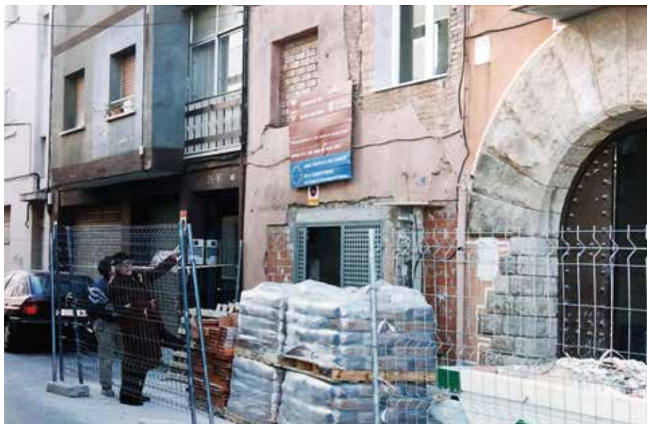
Figura 10. Abelló observa les obres de rehabilitació de la Casa del Pintor, 2000. Font: Fundació Municipal Joan Abelló.
